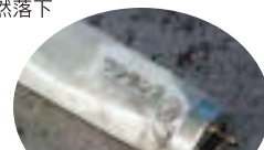
飛散防止膜により、ガラス片の飛散は認められない
